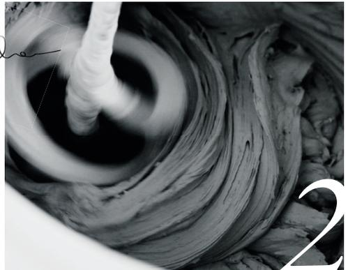
Nun wird der Kalk-Marmorputz mit einer venezianischen Glättkelle in einer Schichtstärke von etwa 2-3 mm innerhalb von 20 Minuten auf die Wandfläche aufgetragen.
